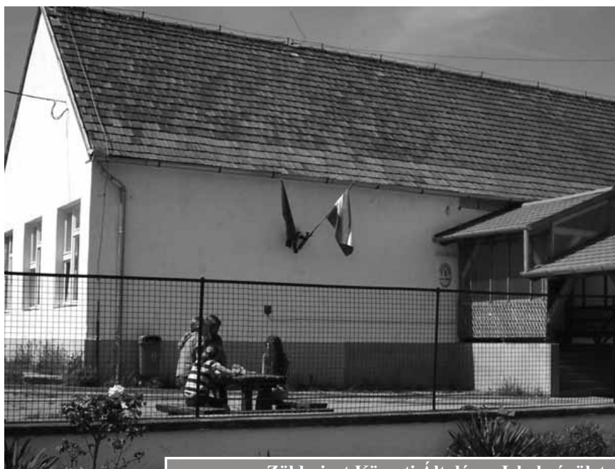
Zöldsziget Körzeti Általános Iskola épülete
